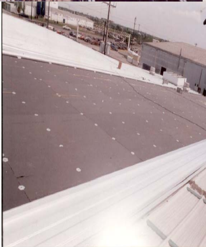
TECHADO Y RETECHADO CON LAMINA STANDING SEAM SECCION KR-18
