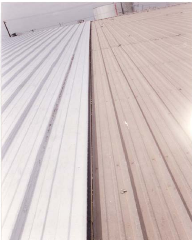
TECHADO Y RETECHADO CON LAMINA STANDING SEAM SECCION KR-18
