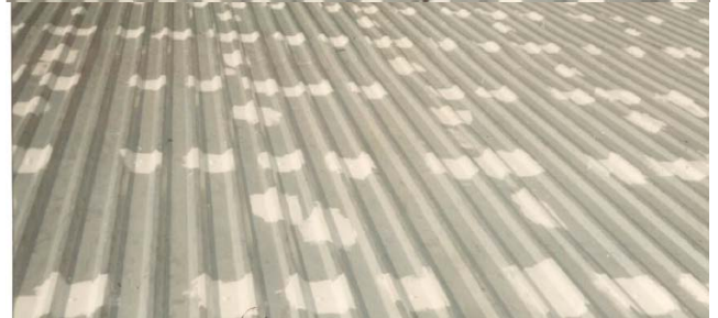
4.- ENCAPSULADO DE TORNILLOS
