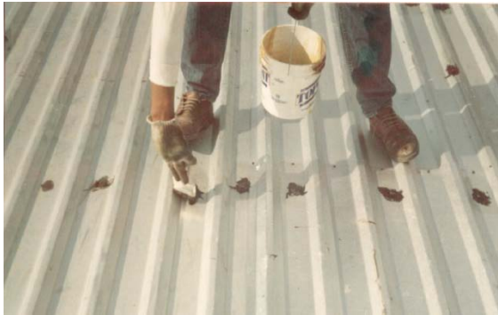
2.- TRATAMIENTO A TORNILLOS CON SELLOS ASFALTICOS APLICACION DE PRECOTE
