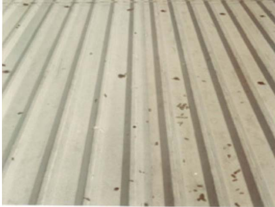
1.-TECHO ANTES DE INICIAR TRABAJOS
