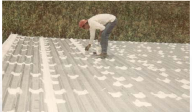
5.- LAVADO A PRESION DE TECHO Y SELLADO DE JUNTAS VERTICALES
