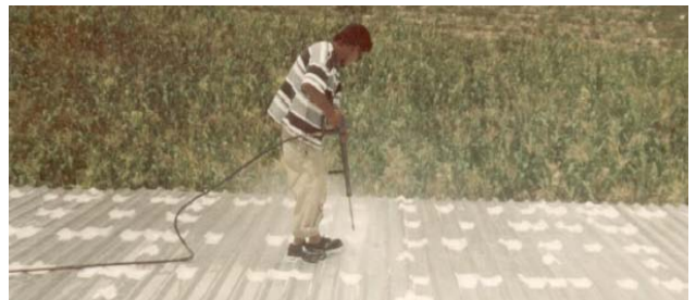
4.- ENCAPSULADO DE TORNILLOS
