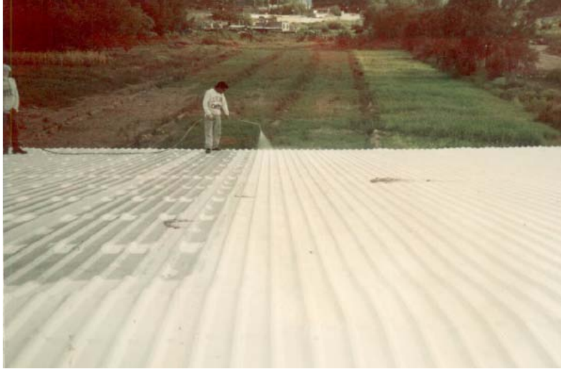
6.- APLICACION DE PINTURA ELASTOMERICA APLICADA CON ASPERSOR
